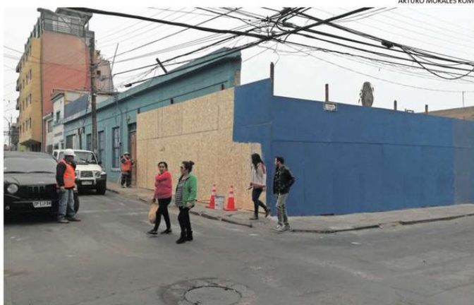
EN ESTA ESQUINA SE PROYECTA LA CONSTRUCCIÓN DE UN EDIFICIO.
